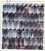
Detalle de una casa chilota reventada de tejuelas de alerce.
